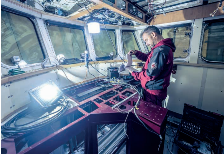
Gährende Leere auf der Brücke der EUGEN vor Vormann Heiko Erdwiens. Neue Elektrik und Elektronik kommen.
