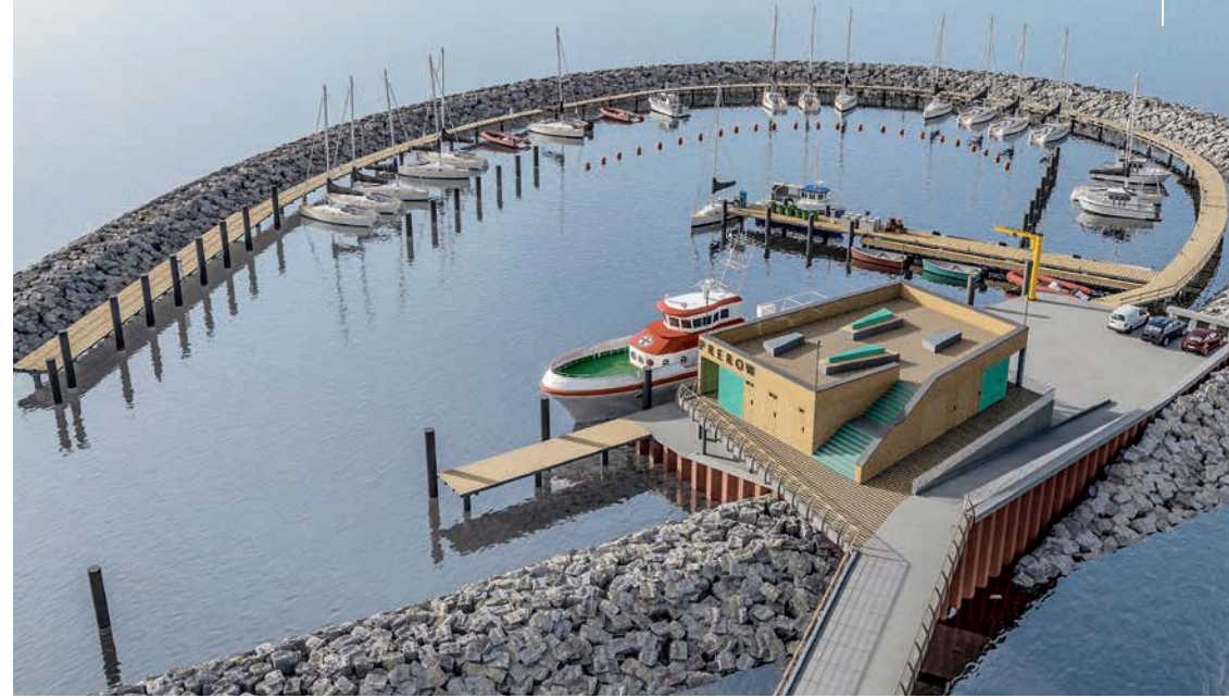
Unverbindliche erste Visualisierung des im Bau befindlichen neuen Inselhafens Prerow, der den Nothafen Darßer Ort ersetzen wird: Der Hafen wird Liegeplatz des Seenotrettungskreuzers NIS RANDERS der Station Darßer Ort/Prerow. Er liegt am Ende einer rund 700 Meter langen Seebrücke vor der Halbinsel Fischland-Darß-Zingst.
