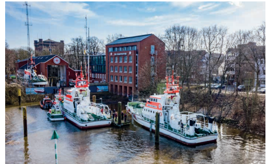
Anleger und Werfthafen der Seenotretter in Bremen. Untergebracht ist in der DGzRS-Zentrale neben der haus-eigenen Werfthalle auch die deutsche Rettungsleitstelle See, das Maritime Rescue Co-ordination Centre (MRCC).
