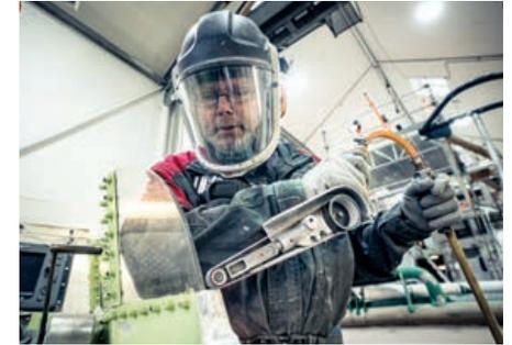
Mit einem Druckluftschleifer entfernt Lackierer Jörg Brümmer die alte Farbe. Anderenfalls bestünde die Gefahr, dass sich Salzeinschlüsse unterm Lack in das Aluminium hineinfressen.
