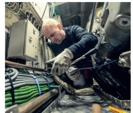
Im Maschinenraum an der Steuerbordseite zieht Elektriker Karsten Gäckle neue Kabel ein.
