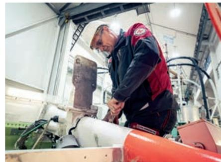
Elektriker Andreas Scholz (60) kümmert sich am Mast der JOHANN FIDI um den richtigen Sitz der Kabel. Später dichtet er sie mit einem Warmschrumpfschlauch ab. Bis zum Jahr 2000 arbeitete er mit seinem großen Schiffbau-Knowhow ebenfalls auf Schweers-Werft.
